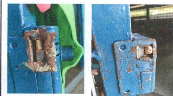
Foto 5: Cambio de chapas de puertas por estar dañadas.
