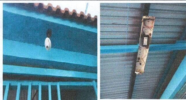
Foto 11: Colocación de nuevas plafoneras
