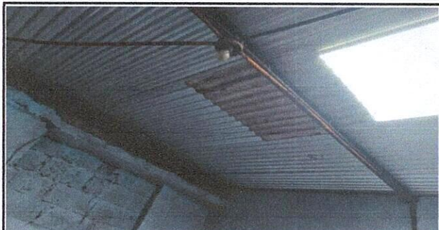
Foto 1: Cambio de lamina fincinc por lámina troquelada.
