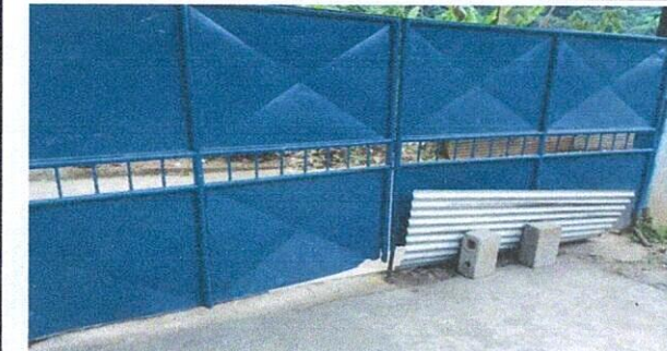
Foto 6: Cambio de portón por estar ne mal estado.
