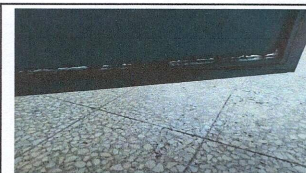
Foto 4: Reparación de puerta metálica y tubo de aula.
