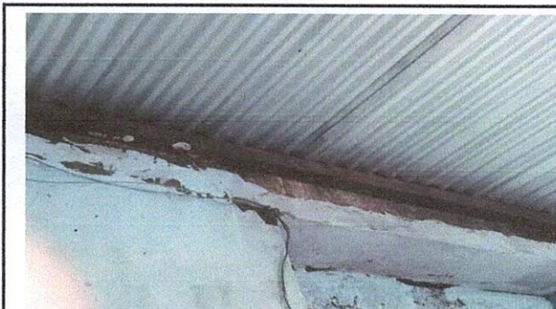
Foto 3: Cambio de estructura metálica en mal estado.
