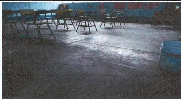
Foto 7: Cambio de piso de cemento líquido por piso cerámico.
